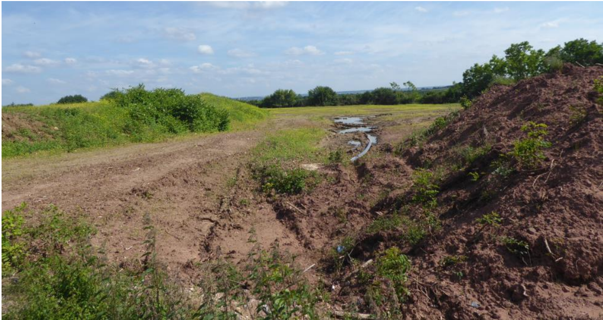
Abbildung 9: Haufwerke und Pfützen im östlichen Teil
