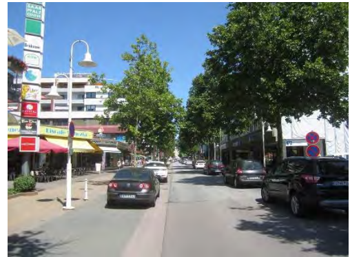
Die Talstraße ist als Haupteinkaufsstraße städtebaulich wenig ansehnlich gestaltet
