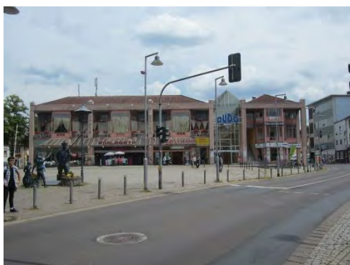
Am Alten Markt sind in der Dudo Galerie die wenigen Filialbetriebe konzentriert. Die Dudo Galerie weist eine eklatante Leerstandproblematik auf
