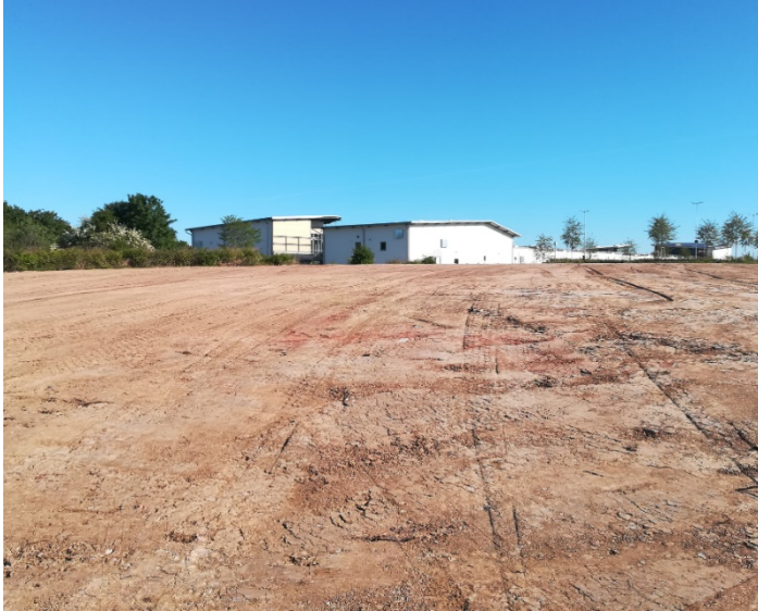
Abb. 10: Vegetationslose Aufschüttung/Planie im Osten des UG
