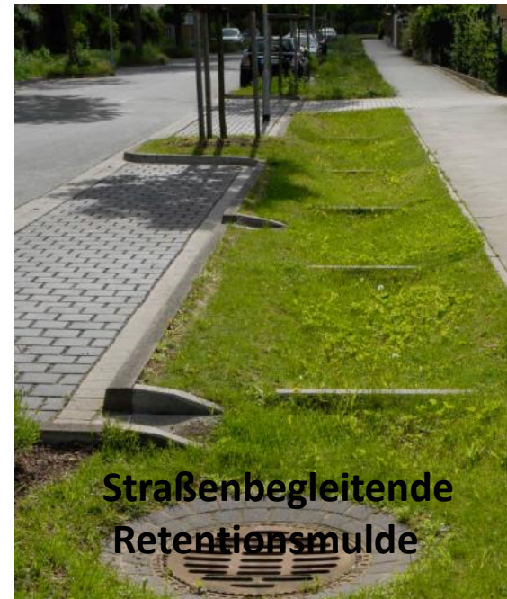
Versickerung über Tiefbeete im Straßenseitenraum
