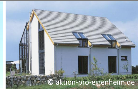
Hitzeschutz durch helle Dächer
