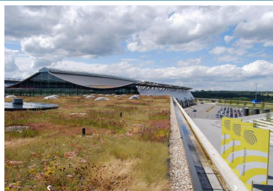
Dachbegrünungspotentiale auf Industrie und Gewerbeflächen in Zweibrücken (links) und extensive Dachbegrünung (Naturdach) (rechts); Quelle: Google Maps und www.benning-dachbegruening.de
