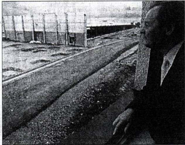
An Fantasie fehlt es Innenminister Zuber nicht: „Dieser Magnet wird Zweibrücken bekannter machen“, meinte er gestern mit Blick auf die Baustelle Designer Outlet. —FOTO: STEINMETZ
