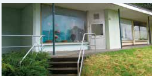
Maßnahme B2: Sanierung Soziales Dienstleistungszentrum
