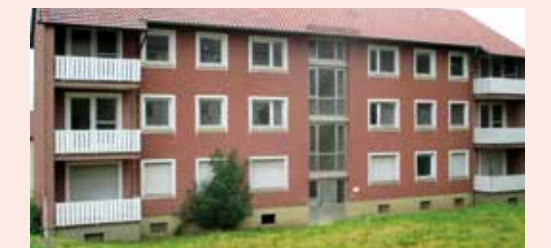
Maßnahme O4: Rückbau und Geländemodellierung in der Quebecstraße 11&13/ Ontariostraße 16&18
